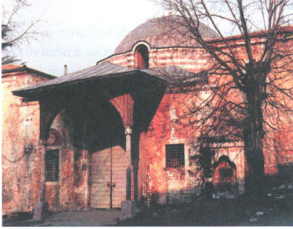
Nurbanu Sultan / Atik Valide İmareti giriş kapısı. (Nil Sarı arşivi, 1988)
