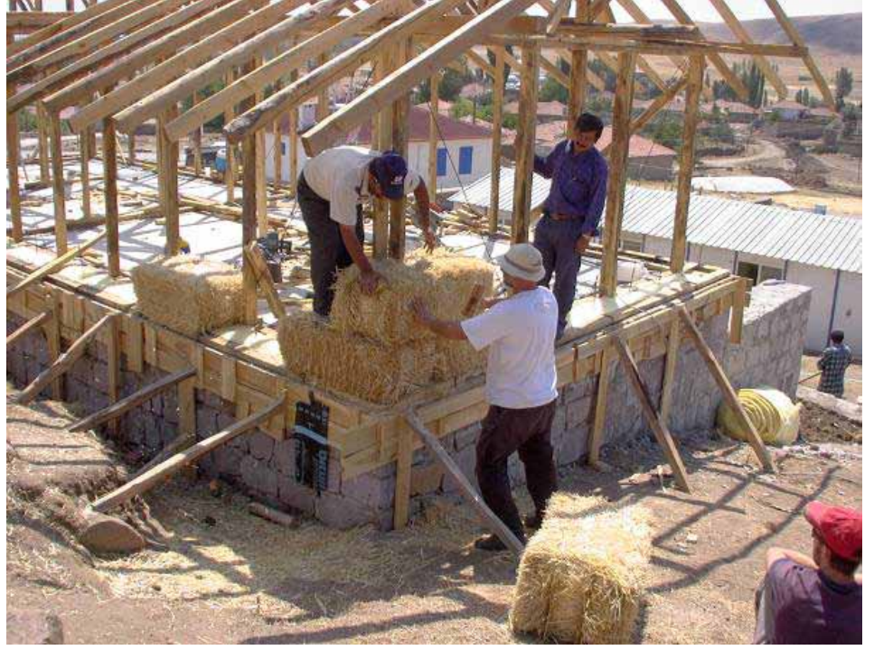
Ahşap konstrüksiyonu tamamlanan yapının duvarları saman balyalarıyla örülüyor.
