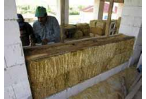
Dolgu malzemesi olarak kullanılan saman balyalarının dış yüzeyleri gaz betonla kaplanıyor.
