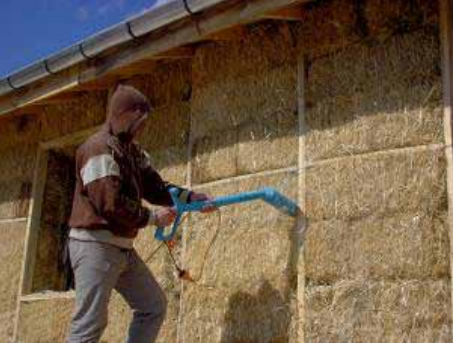
Saman balyaları sıva için hazırlıyor
