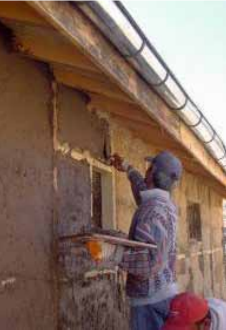
Saman balyalarının üzeri kerpiçle sıvanıyor
