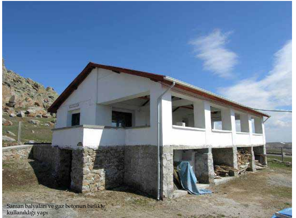
Dolgu malzemesi olarak kullanılan saman balyalarının dış yüzeyleri gaz betonla kaplanıyor.
