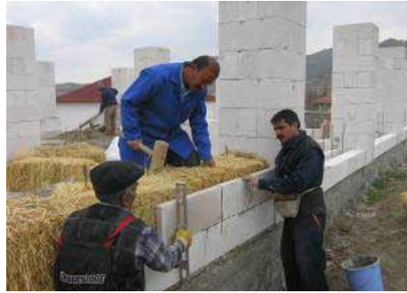
Dolgu malzemesi olarak kullanılan saman balyalarının dış yüzeyleri gaz betonla kaplanıyor.
