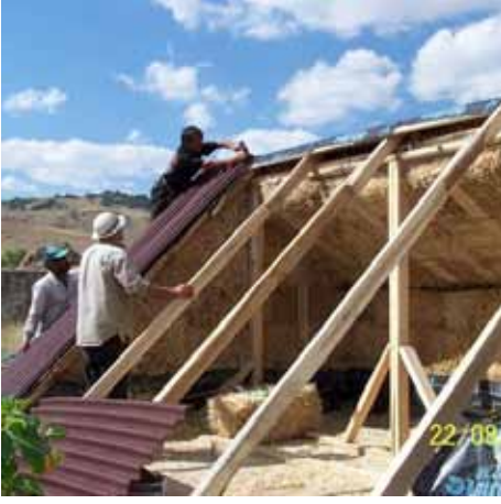
Sera yapımında kuzeyden ısı kaybını engellemek için saman balyaları kullanılıyor.
