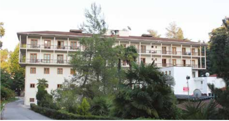
Günümüzde batı (havuz) yan cephe
