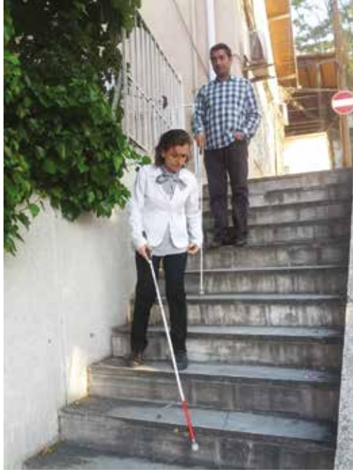
Merdiven kenarları kontrast renklerdeki kuşaklarla belirginleştirilmeli, iki basamaktan fazla olan merdivenlerde trabzanlar bulunmalıdır.
