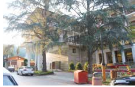
Günümüzde güney ön cephe
