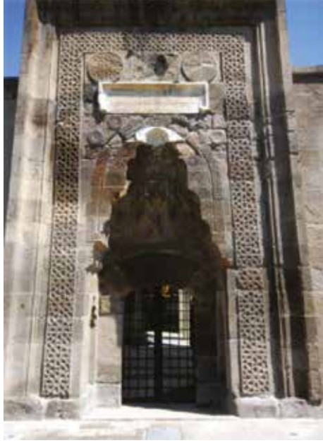
Kayseri Gevher Nesibe Darüşşifası'nın abidevi taę kapısının onarım sonrası fotoğrafı.
