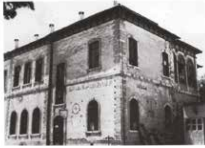
Ziver Paşa Konağı'nın yandan görünüşü. Duvarda sağda, "iştirakiye", solda, "El-İttihadü'l-Vataniyyeti't-Talebeti Suriye (...)" yazılı.
