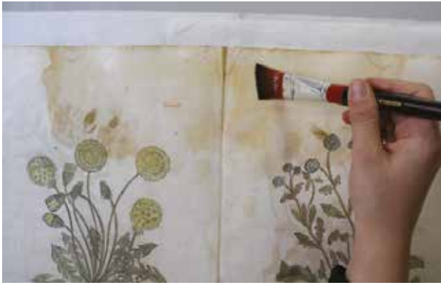
Şekil 44 – Hidroksipropil selüloz ile sağlamlaştırma
