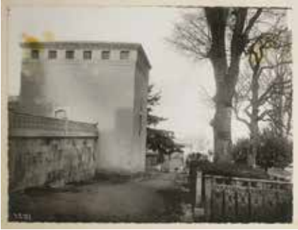
Hekimbaşı odası dış cepheleden görünüm. 1945 yılı Topkapı Sarayı onarımları sırasında çekilen fotoğrafı TSM.13-55-52
