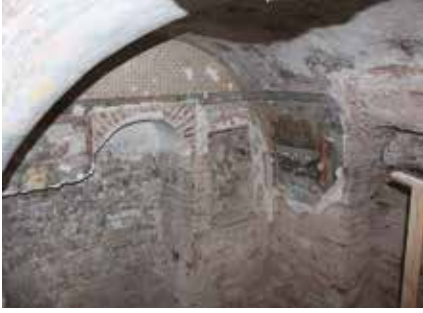
Harem Kuşhane Mutfağı-onarımlar sonrasında çıkan duvar resimleri
