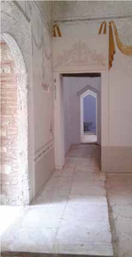
Harem Hastane avlusunun uzun kenarındaki hamam kompleksi- onarım sonrası
