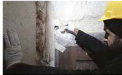
Harem Karaağalar dairesinin onarımları sırasında kapı sövesi içine gizlenmiş diş- pamuğa sarılı tırnaklar ve kağıda yazılı Halil isimli birine yazılmış fevk
