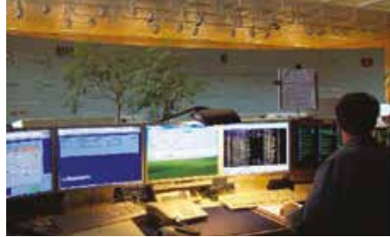
Teknik aksam kontrol panelleri
