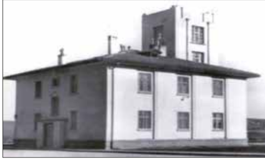
Veteriner Hekimliği Tarihi Müzesi Binası
