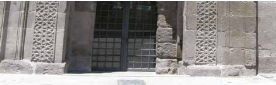
Kayseri Tıp Medresesi ve Darüşşifası. Yükseltilen yol kotu, Kitabe ve farklı malzeme ile tamamlama (ggc.arş. 2018)
