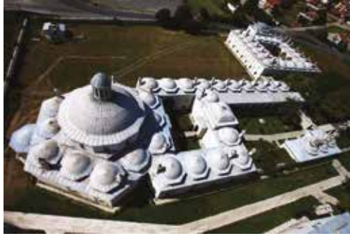
Edirne Sultan II. Bayezid Darüşşifası ve Tıp Medresesi
