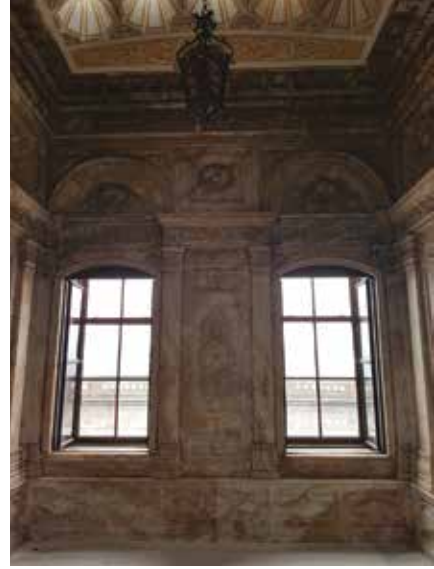
Selamlık Hünkâr Hamamı Ilıklık bölümü
