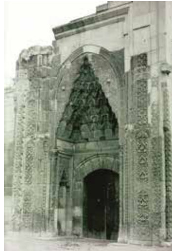
Amasya Darüşşifası, solda 1967 öncesi onarım ve özgün yol kotu, sağda yükseltilmiş yol kotu sebebiyle Taçkapı subasmanlarının gömülmüş durumu (ggc.arş. 1967 ve 2018)
