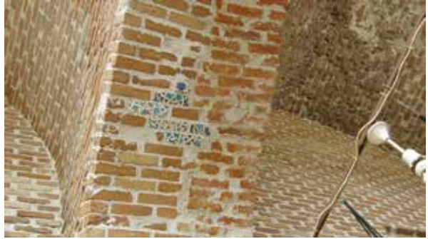
Sivas, revak kemer dokusunda çini-tuğla beraberliği, derz ve sırlı tuğla yüzey tahribatı (ggc.arş. 2018)
