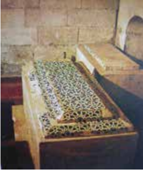
Sivas, kümbetteki çini sanduka kaplamalarında sağda hatalı yeni üretim çinilerle tamamlama (ggc.arş. 2018)
