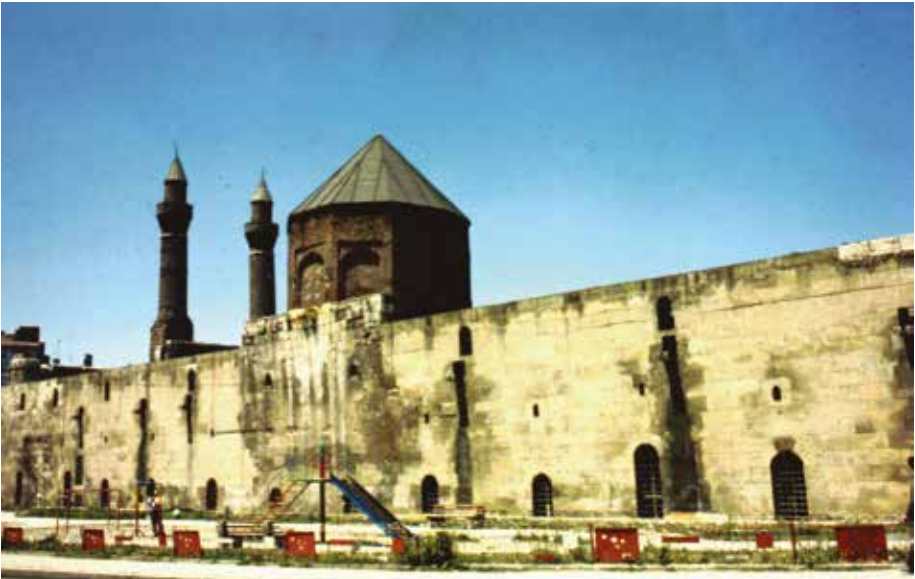
Sivas İzzeddin Keykavus I. Darşşifası 1217, Osmanlı Dnemi onarımının tespit edildięi cephe (ggc. arř. 1966)
