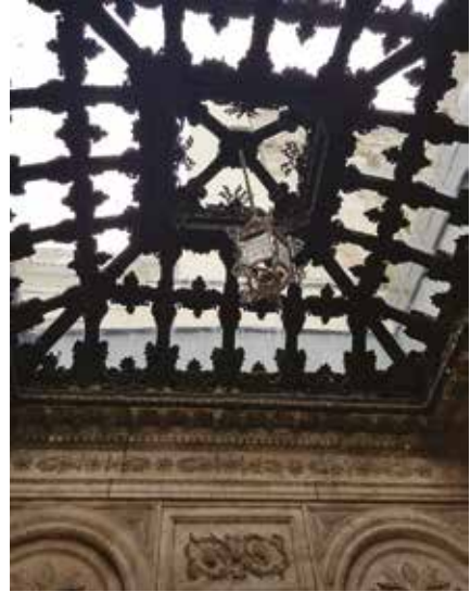
Selamlık Hünkâr Hamamı'nın çelik konstrüksiyonlu tavanı
