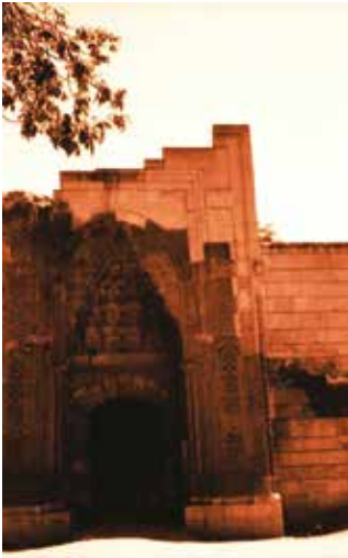
Amasya Darüşşifası, solda 1967 öncesi onarım ve özgün yol kotu, sağda yükseltilmiş yol kotu sebebiyle Taçkapı subasmanlarının gömülmüş durumu (ggc.arş. 1967 ve 2018)
