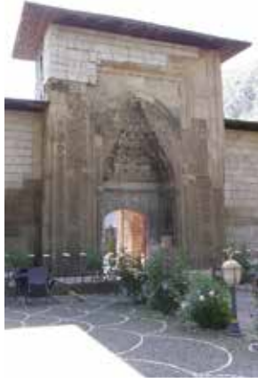
Amasya Darüüşşifası, onarım kurallarıyla örtüşmeyen uygulama (ggc.arş. 2018)
