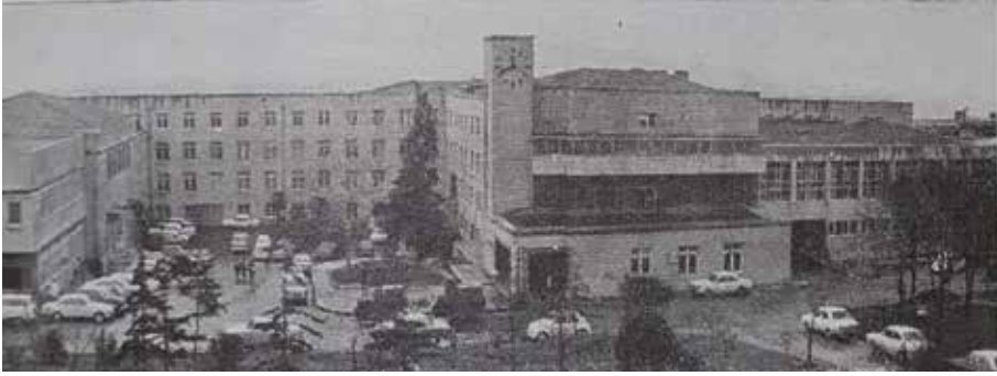
8 no'lu yapı, kuzey cephesi, Manizade, 1976 20
