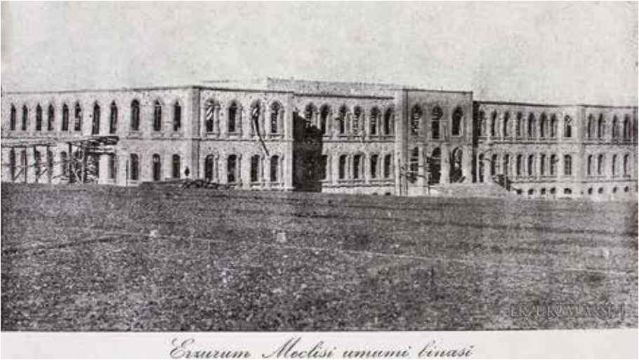
Resim 5: Erzurum Meclis-i Umumi binası 17
