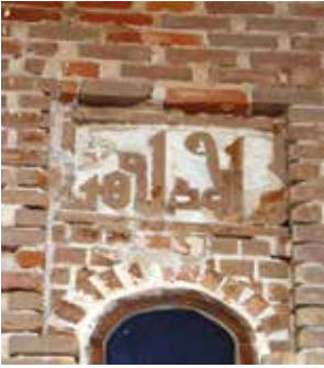
Sivas, ana eyvanda tuğla kitabede temizlik adına derz tahribi ve aydınlatma eki (ggc.arş. 2018)
